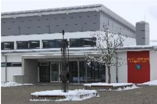
Eine der ersten Veranstaltungen in der neu renovierten Alemannenhalle war die Einschulung der Erstklässler.
